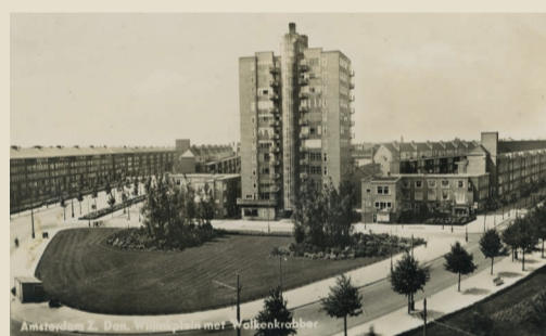
Die Franks ziehen in den Süden von Amsterdam. In der Nähe steht der »Wolkenkratzer«. Er ist damals eines der höchsten und modernsten Gebäude der Stadt.
